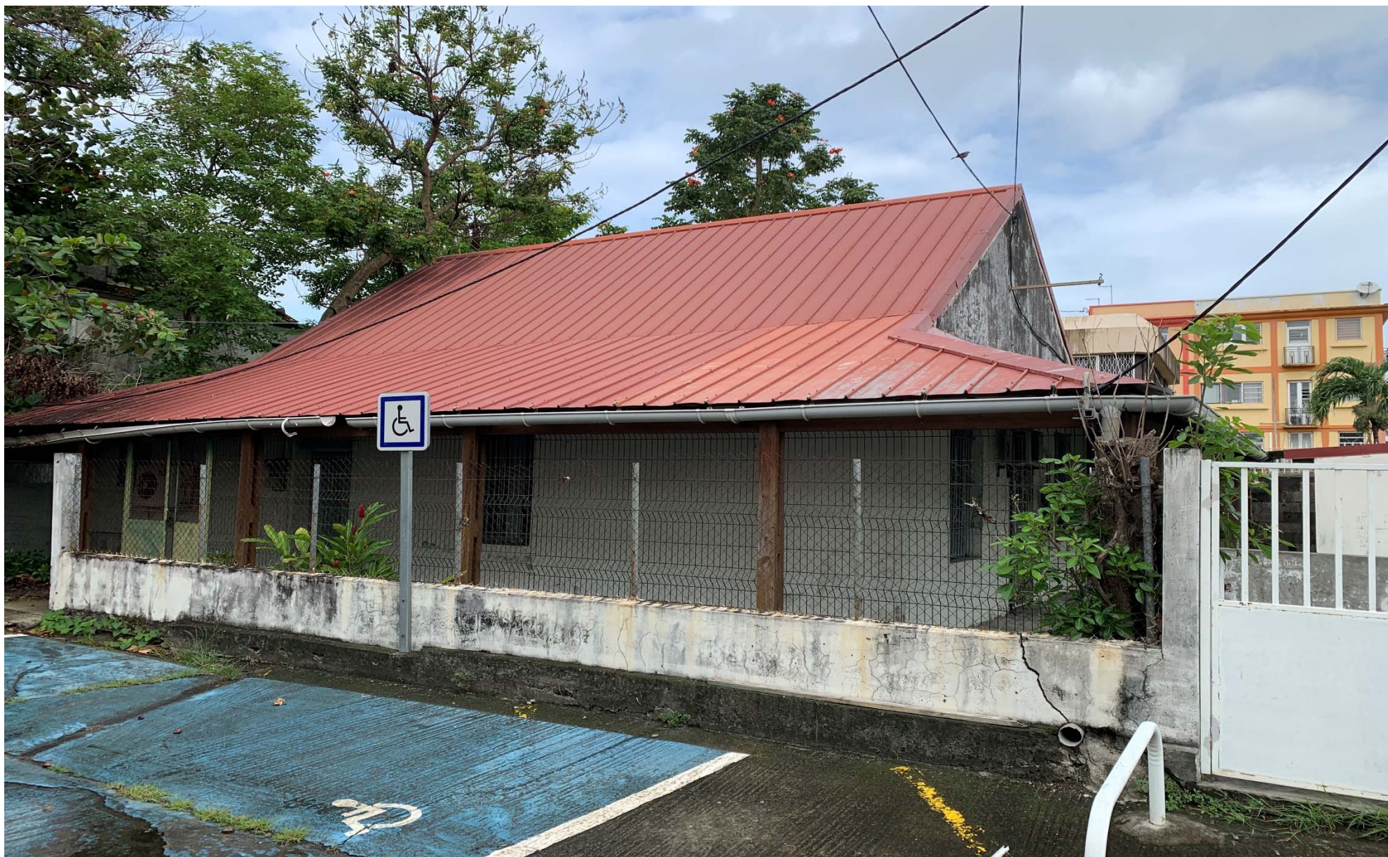
Photo 1 - Façade extérieure du bâtiment à réhabiliter
