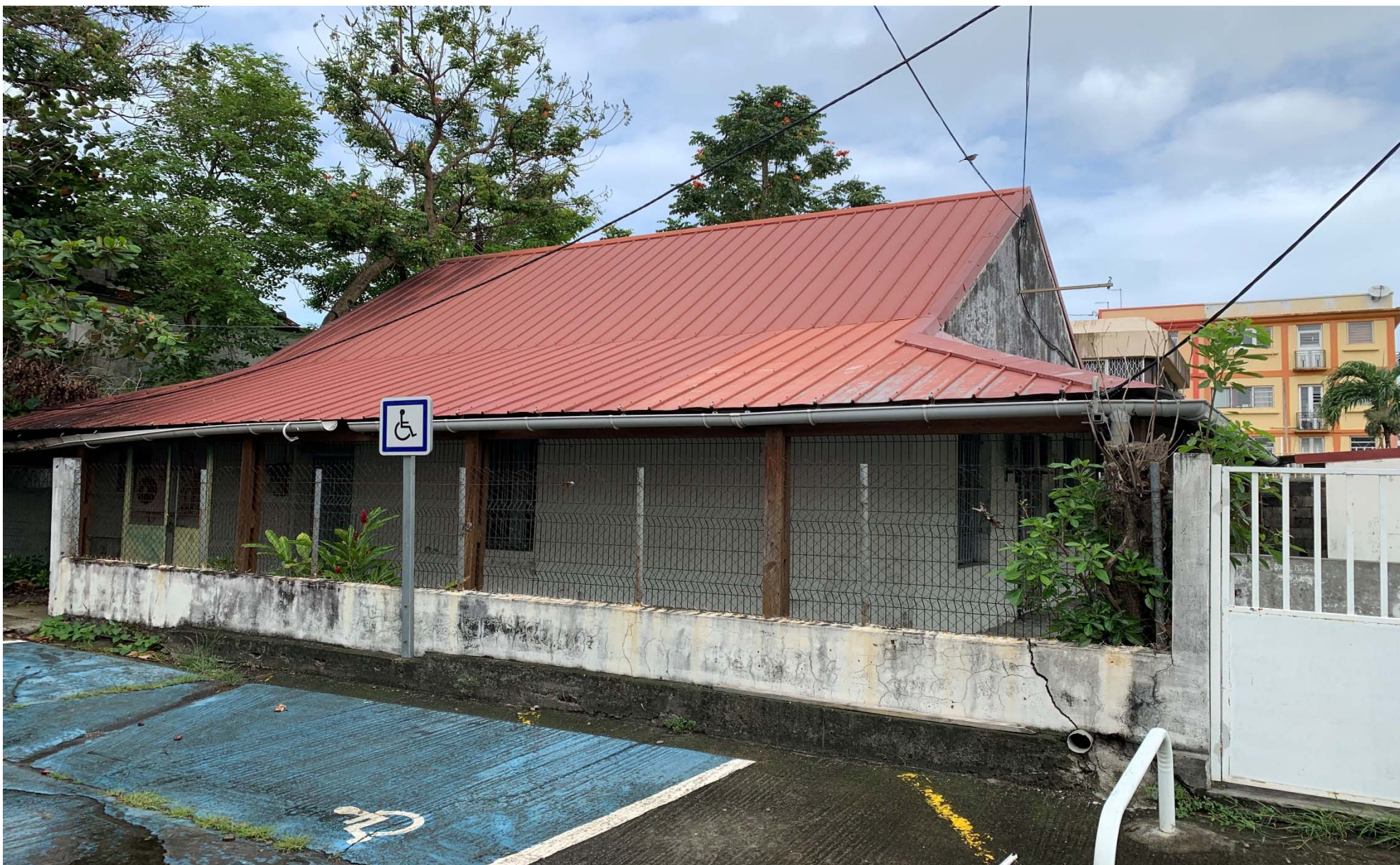
Photo 1 - Façade extérieure du bâtiment à réhabiliter
